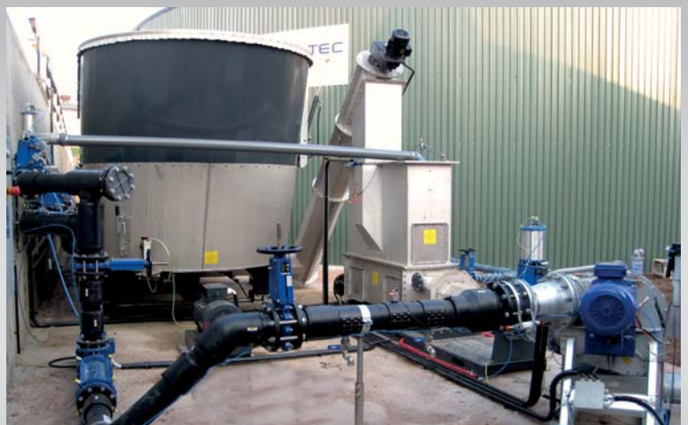
MULTIMix измельчает субстрат и отделяет посторонние примеси.
