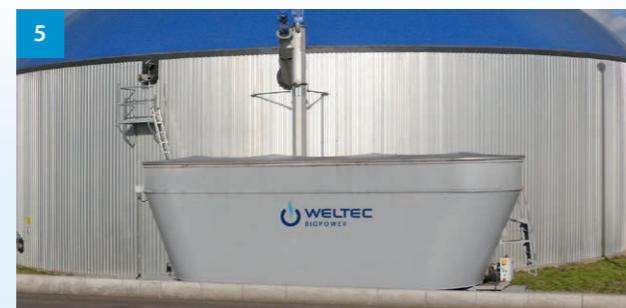
**Vertikaldosierer** · Vertical dosifier · Doseur vertical · Dosatore verticale · Dosificación vertical · Дávkoвáč pevných substrátů · Вертикальный дозификатор
