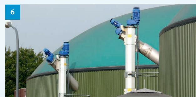
**Stopfschnecken** · Fermenter screw · Vis de gavage · Coclee · Tornillo de tapón · Fermentorové šnekы · Винт ферментера
