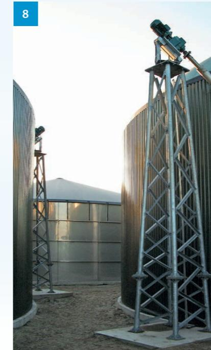
**Außenstütze Langachsrührwerk** · Outside support for axial agitator · Support extérieur d'agitateur axial · Supporti esterni per agitatori assiali · Sustento externo del agitador axial · Venkovní stojár pro míchadlo na dlouhé hřídele · Внешняя поддержка осевого смесителя
