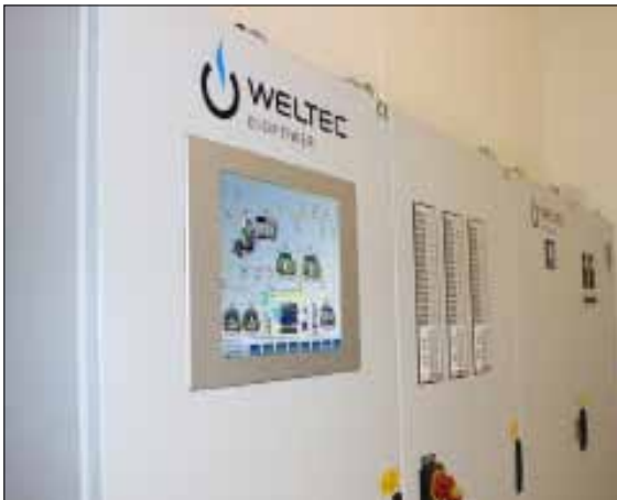
In Südkorea wird die optimale Funktionsweise der Komponenten durch die von WELTEC selbst entwickelte LoMOS Steuerung auf SPS-Basis geregelt.
